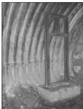
Soporte de la prensa hidráulica en la galería metálica del taller principal.
